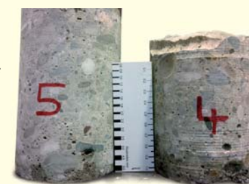
Die Bohrkern der alten Betonssole des Vereinsheims wurden durch ein Labor untersucht. Die Ergebnisse fließen in die Konstruktion der neuen Sohle ein.
